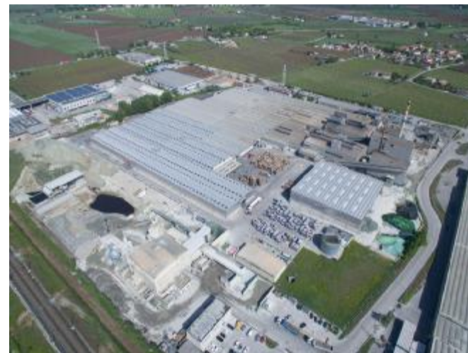
Una veduta dello stabilimento ad Almisano di Lonigo
