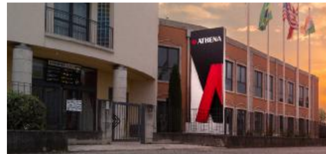
Uno scorcio dello stabilimento Athena ad Alonte
